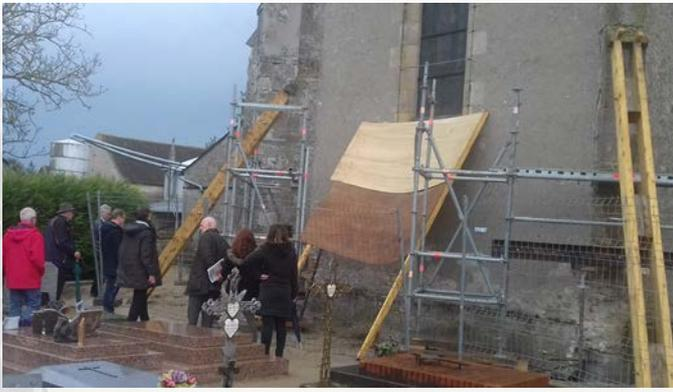
Une tâche éphémère, mais indispensable. Les charpentiers, les couvreurs et les maçons restaurent le clocher, la toiture est totalement rénovée, la charpente est remaniée avec une couverture en ardoises. Un clocheton va être remis en place. Vrigny va retrouver son Clocher.
