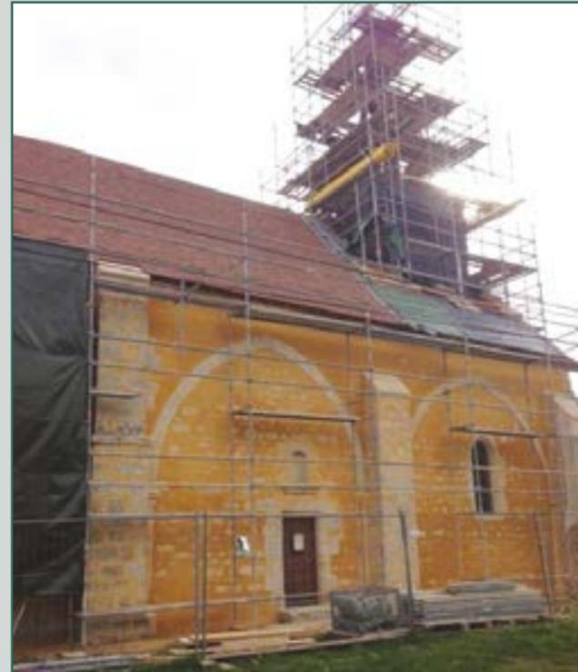
Les travaux débutent le 7 avril 2015 par un premier chantier concernant le drainage, puis ensuite la toiture complète du bâtiment, ainsi que celle du clocher et la restauration des façades. Les travaux dureront plus de 8 mois. L'église ainsi mise « hors d'eau », avec une toiture toute neuve, des nouveaux enduits extérieurs, les travaux intérieurs peuvent débuter au printemps 2016.
