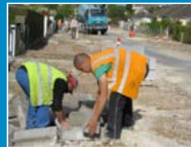
Manœuvre en entreprise
